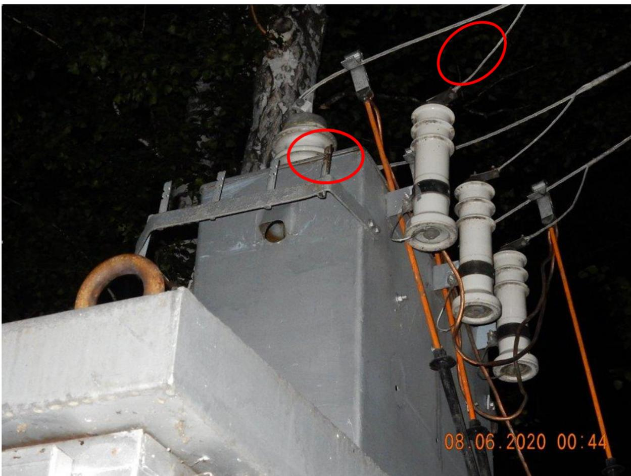
Фотография №6. Место прикосновения (траверса-шлейф разрядника).
