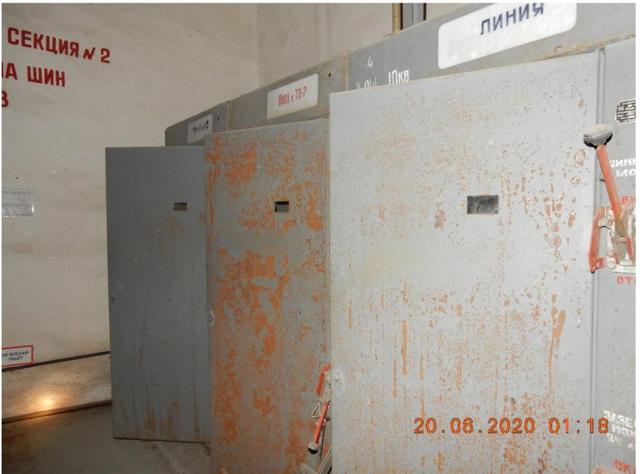
Фотография №3. Ячейки 2-й секции ТП-42. Двери ячеек открыты.
