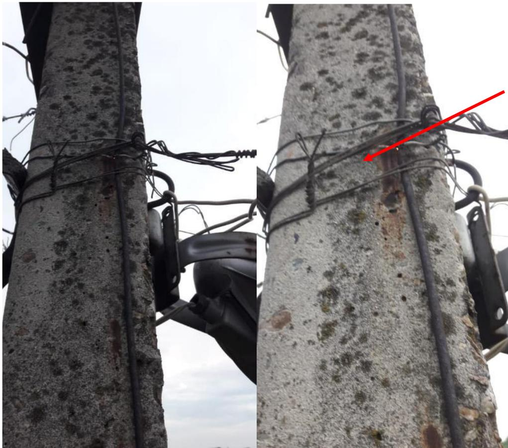
Фотография №6. Следы перекрытия на заземляющем спуске.
