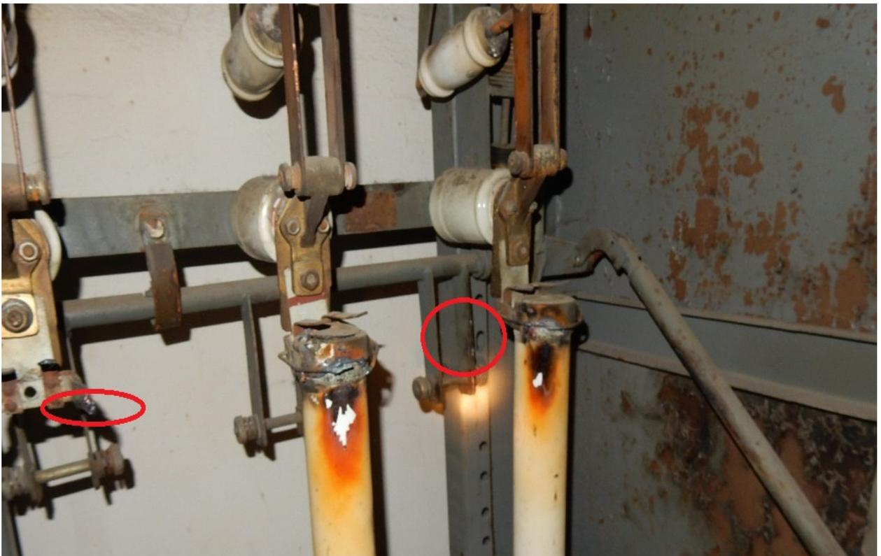
Фотография №4. Следы короткого замыкания в ячейке РУ 10 кВ Т-2.
