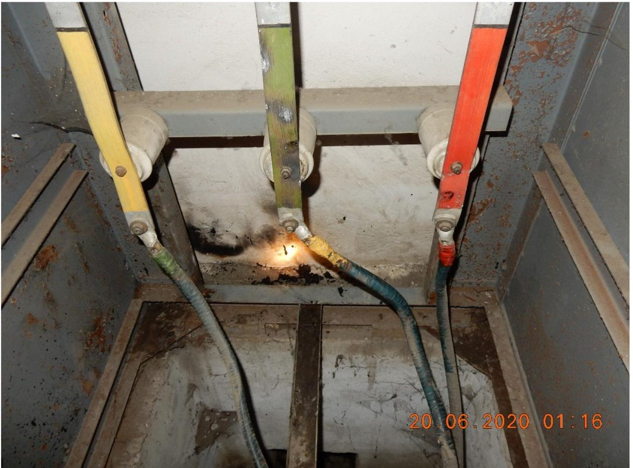
Фотография №5. Следы воздействия электрической дуги и остатки горелой одежды в ячейке РУ 10 кВ ТП-42.
